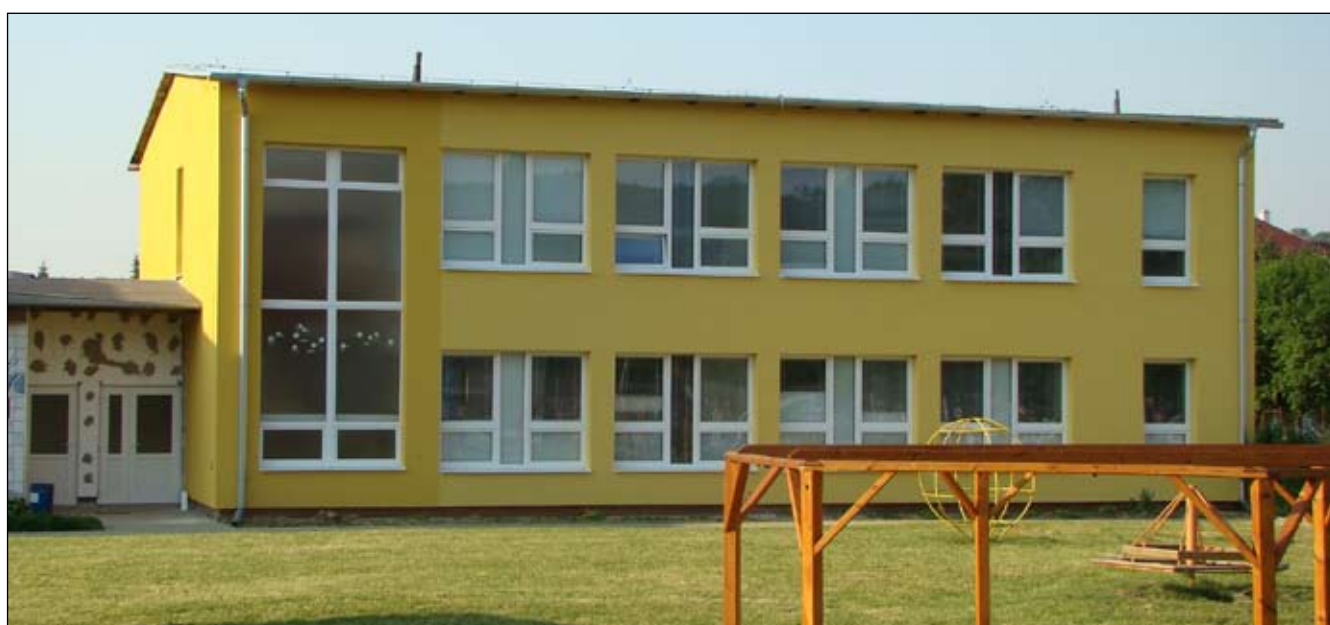
Zrekonštruovaná základná škola.
