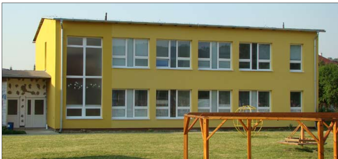
Zrekonštruovaná základná škola.
